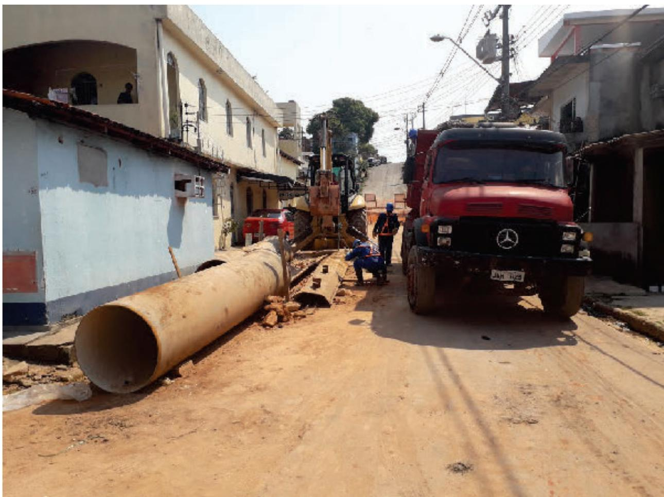
*Como foram construídos imóveis sobre a adutora, uma nova rede de água foi implantada paralelamente à estrutura da antiga*
