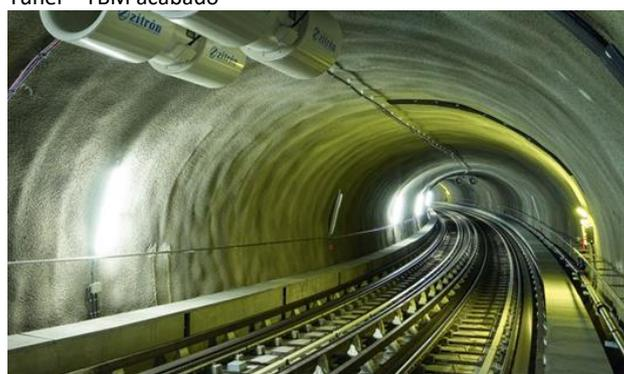
Túnel típico construído pelo Método NATM
